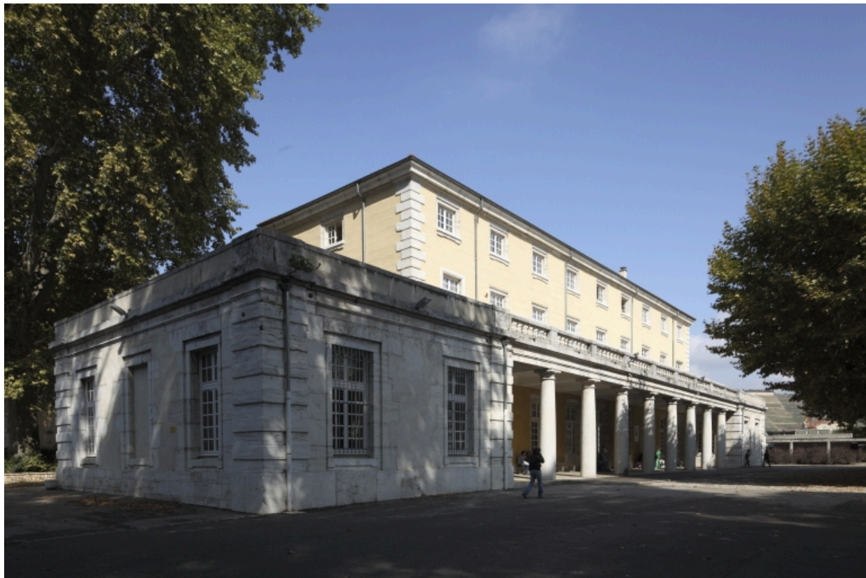
Bâtiment C. Vue d'ensemble de la façade sud, venant achever l'extension des oratoriens.
