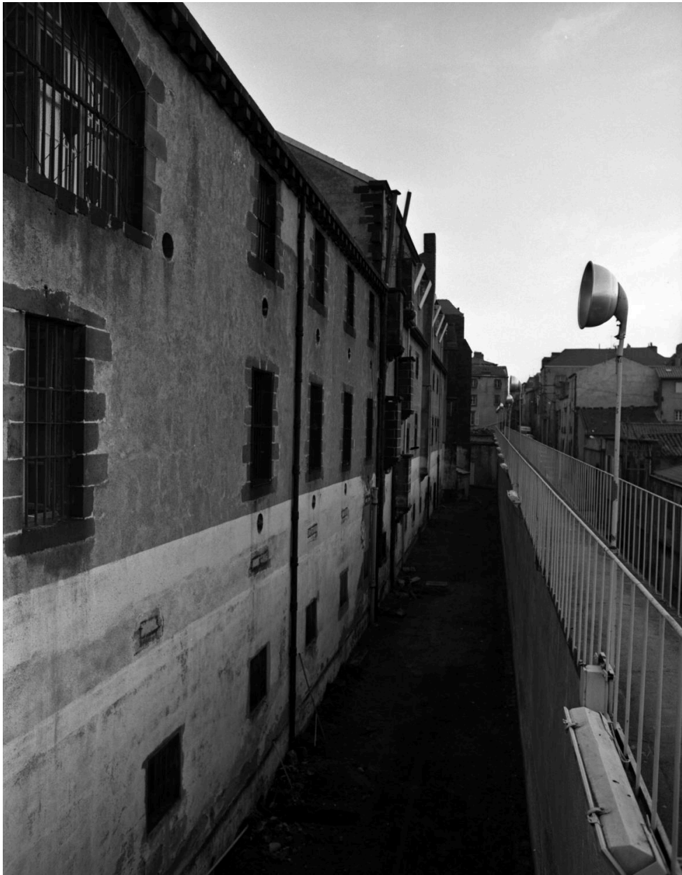
En 1986 (avant démolition de cette partie du bâtiment D), élévation ouest.
