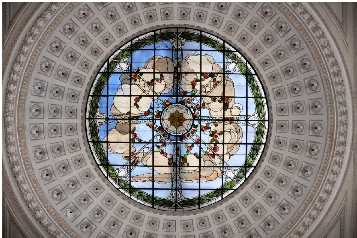
Oculus zénithal vu du dessous
