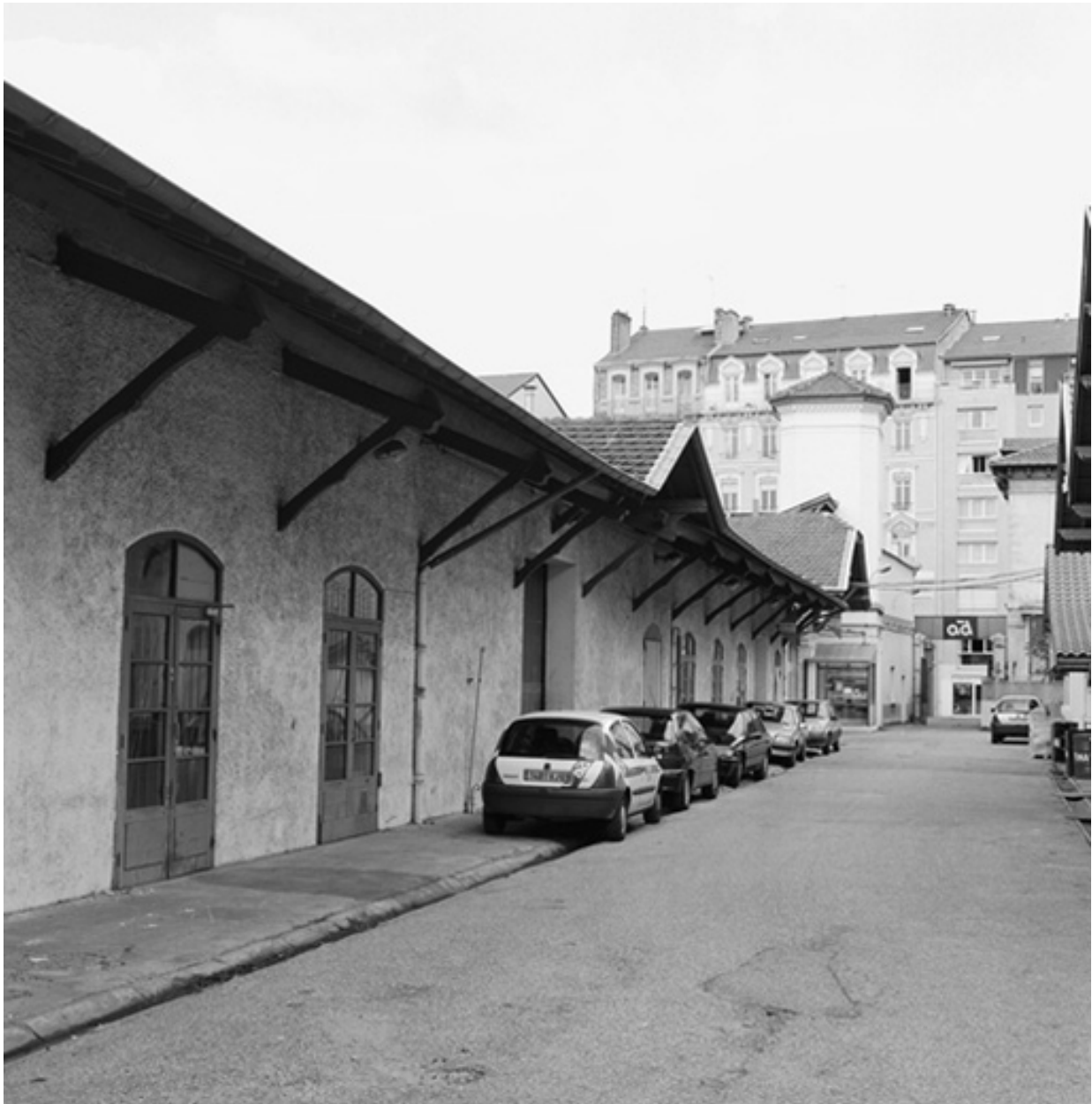
Vue d'ensemble des box-ateliers, sud
