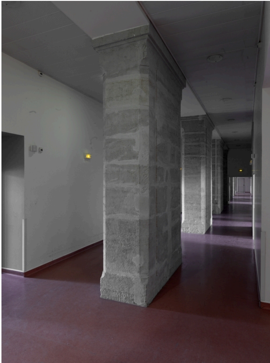
Bâtiment B. Alignement des piliers du 1er étage
