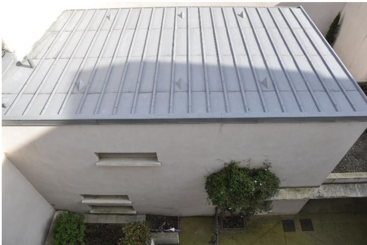
Vue sud du bâtiment sur cour
