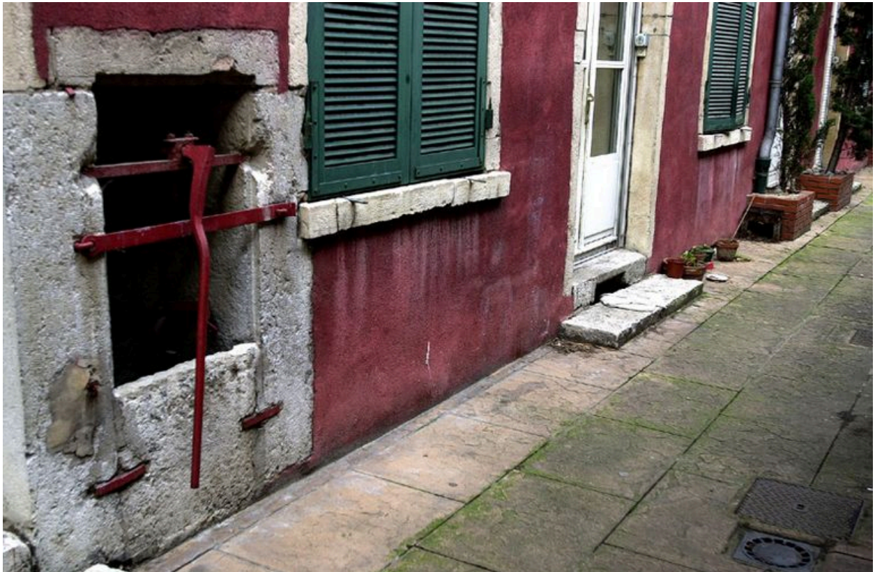
Rez-de-chaussée des dépendances à l'est de la cour
