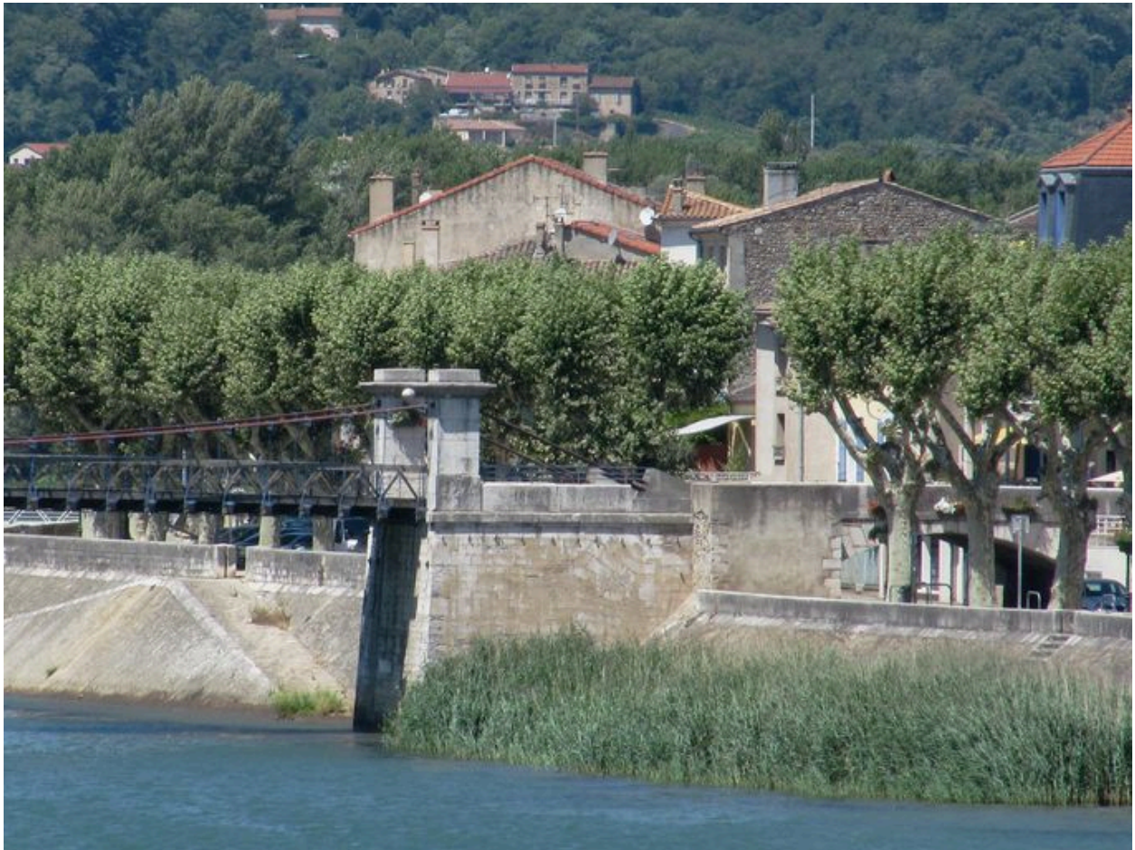
Vue partielle, culée gauche, face aval (depuis le pont Toursier)
