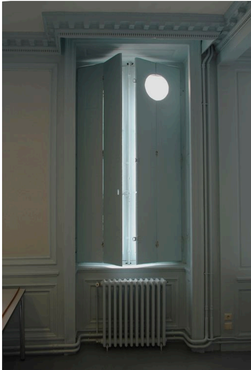
1er étage, pièce donnant sur rue, baie et volets.
