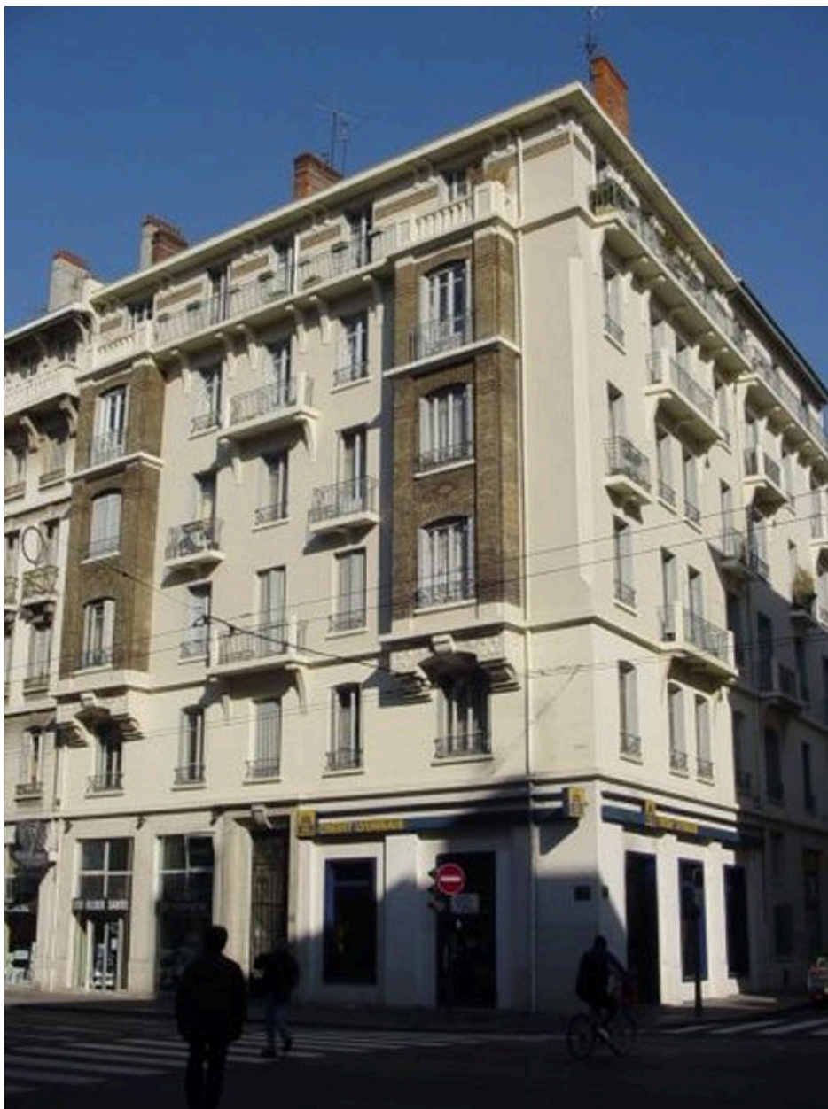
Vue générale de l'élévation
