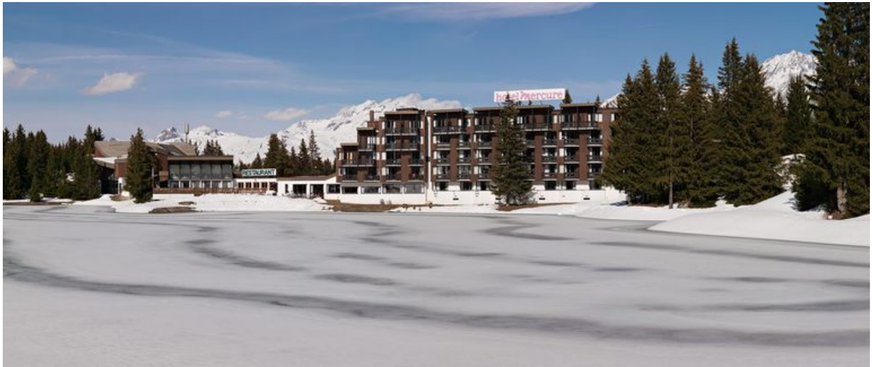
Vue d'ensemble de l'Auditorium et de l'hôtel depuis le lac des Verdons à l'ouest
