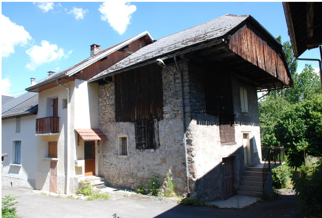
Impasse Taillanderie, exemple d'extension de fenil en porte-à-faux (2018 I1 1297).
