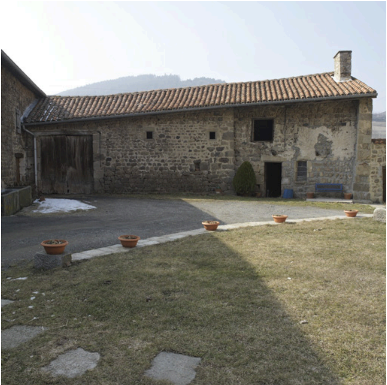
Vue d'ensemble du logis ancien et de la grange depuis l'ouest.
