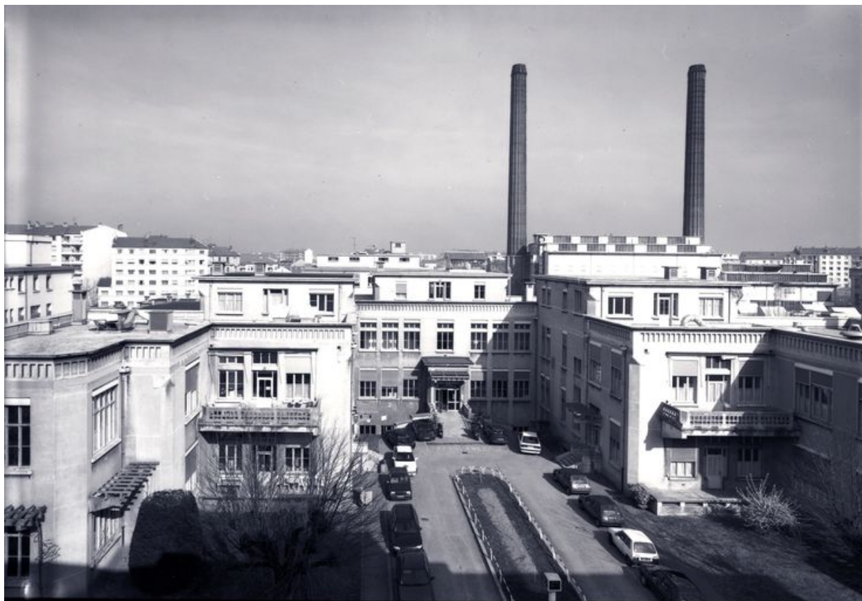
Les cheminées de la chaufferie à l'arrière du pavillon D, avant leur démolition en 1997
