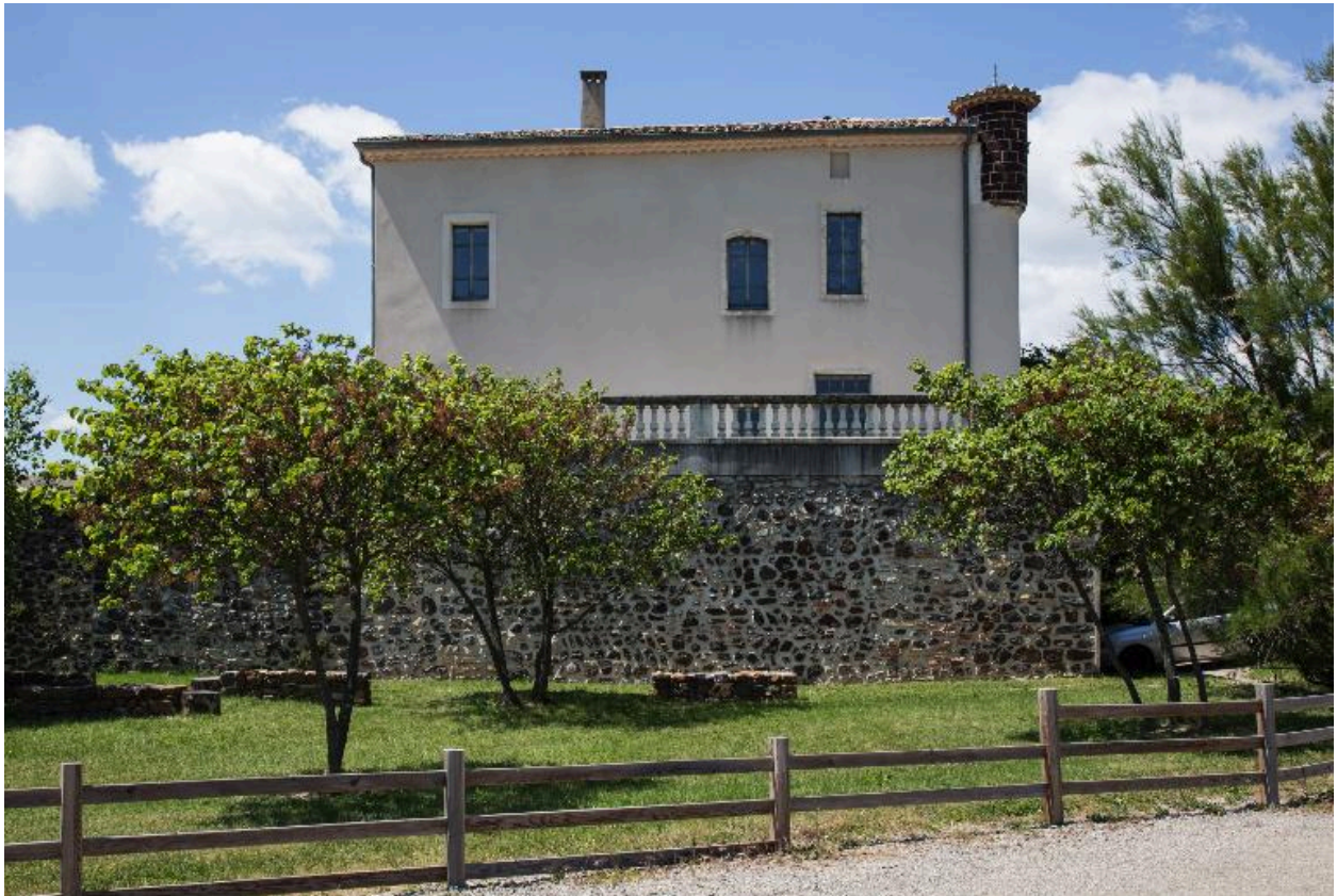
Bastide : façade ouest
