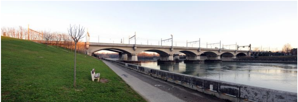
Vue panoramique, face aval (depuis la rive droite)
