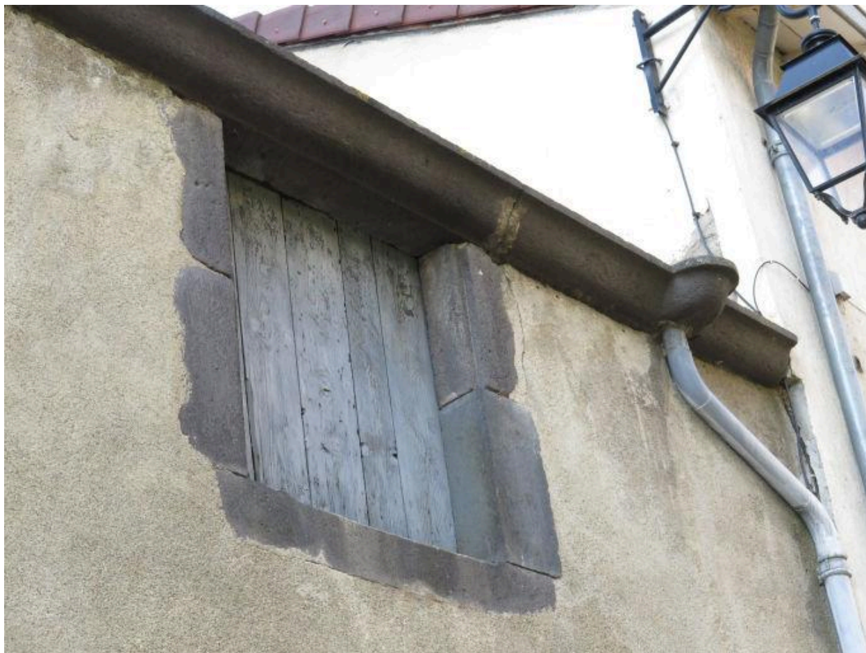
Corniche avec cuvette d'évacuation : Beaumont, 13 rue du 11 novembre
