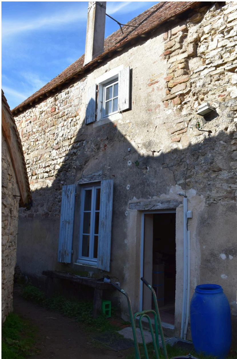
Détail du mur gouttereau méridional.
