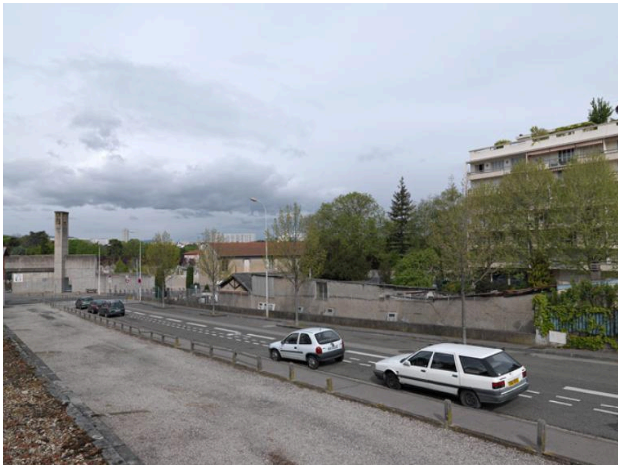
Vue d'ensemble depuis la rue Louis-Pize
