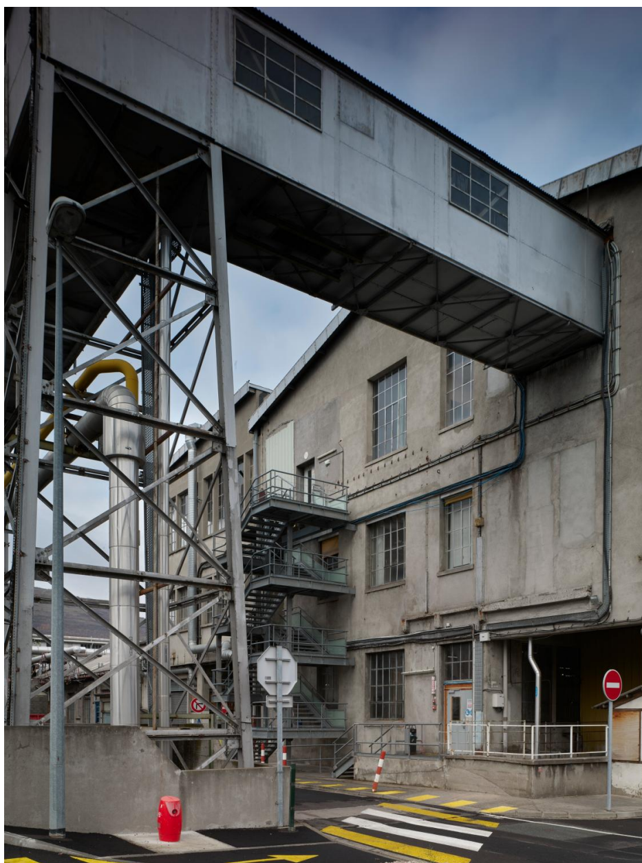
Une passerelle technique, à son embranchement avec le bâtiment T50.
