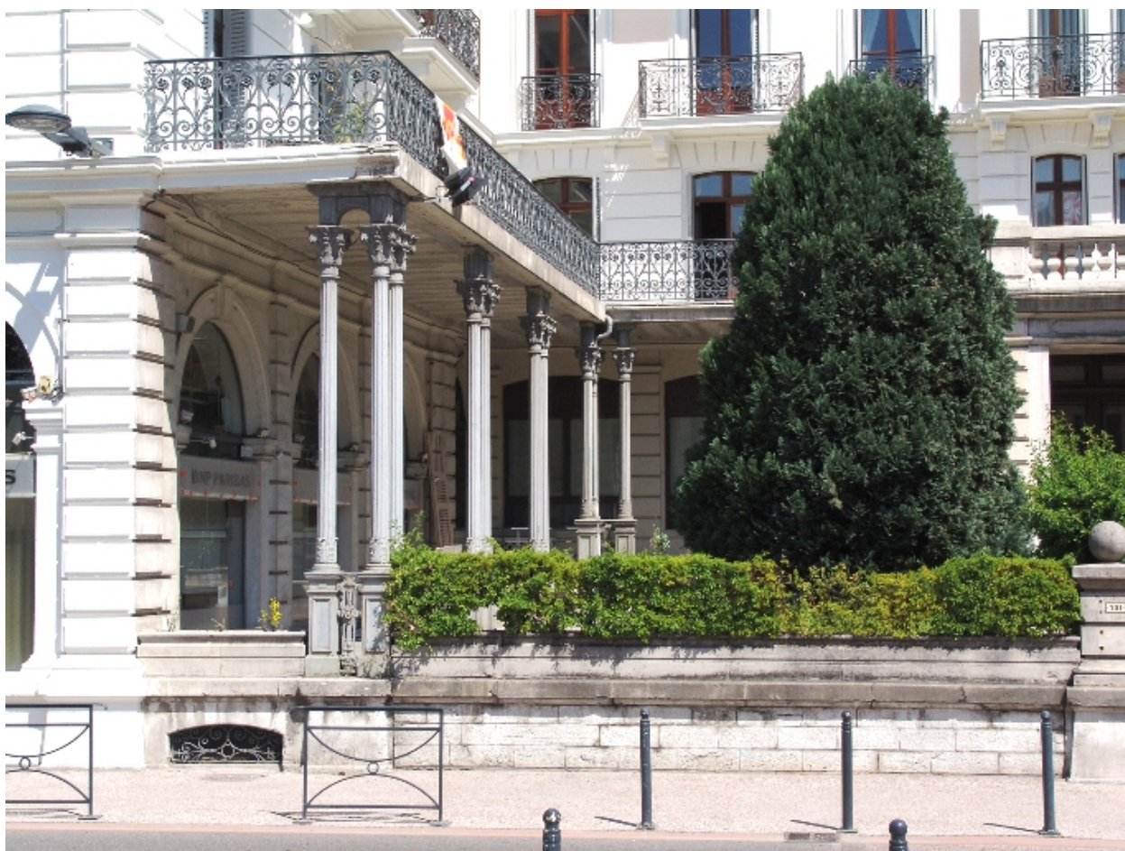
Détail du balcon nord
