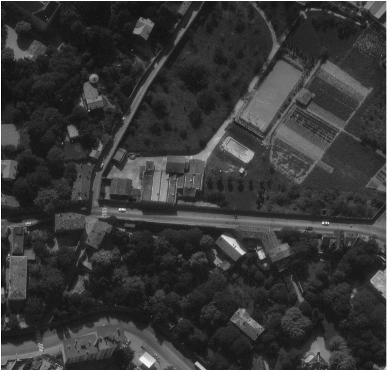
Détail du site : vue aérienne de 1972 (archive privée)
