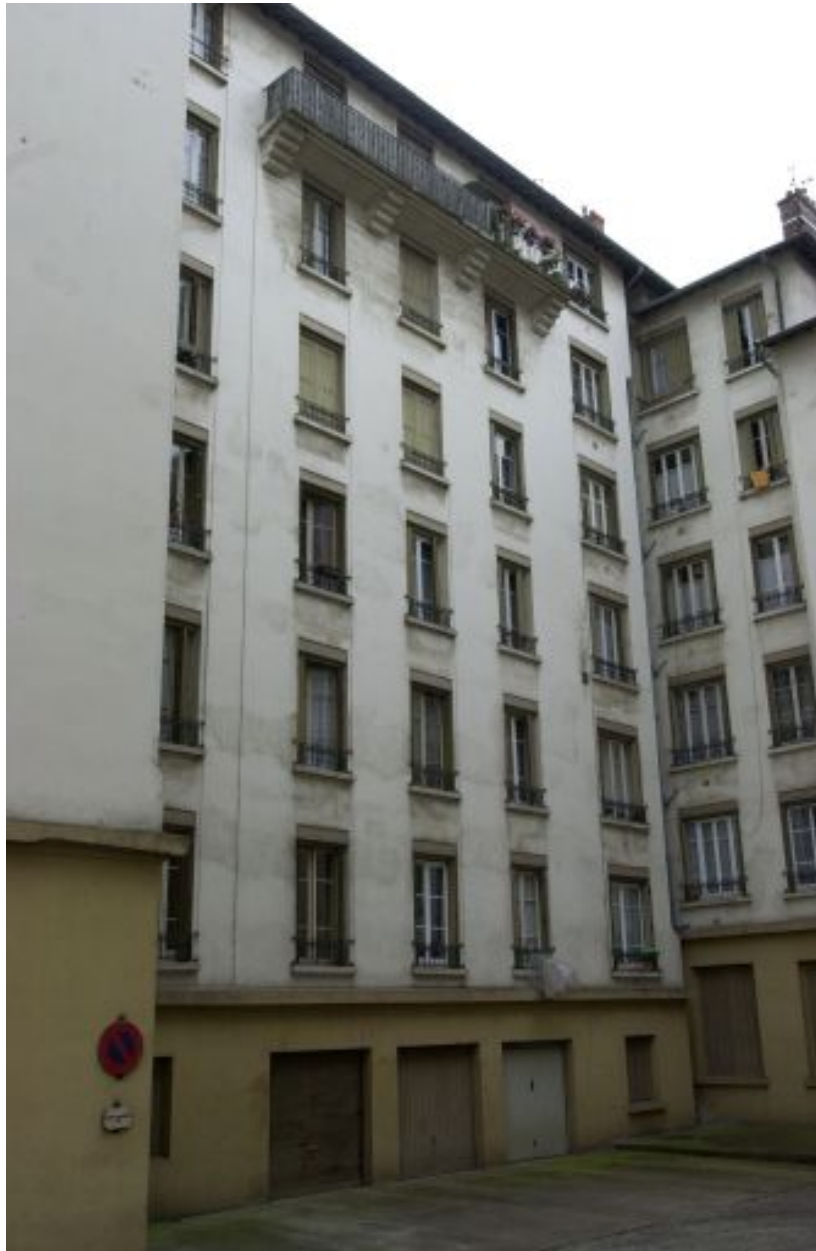
La cour des 34-36 rue Quivogne, angle sud-ouest
