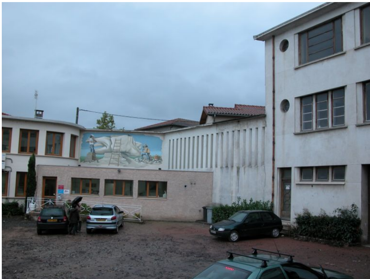
Partie sud de l'entrée de l'usine.
