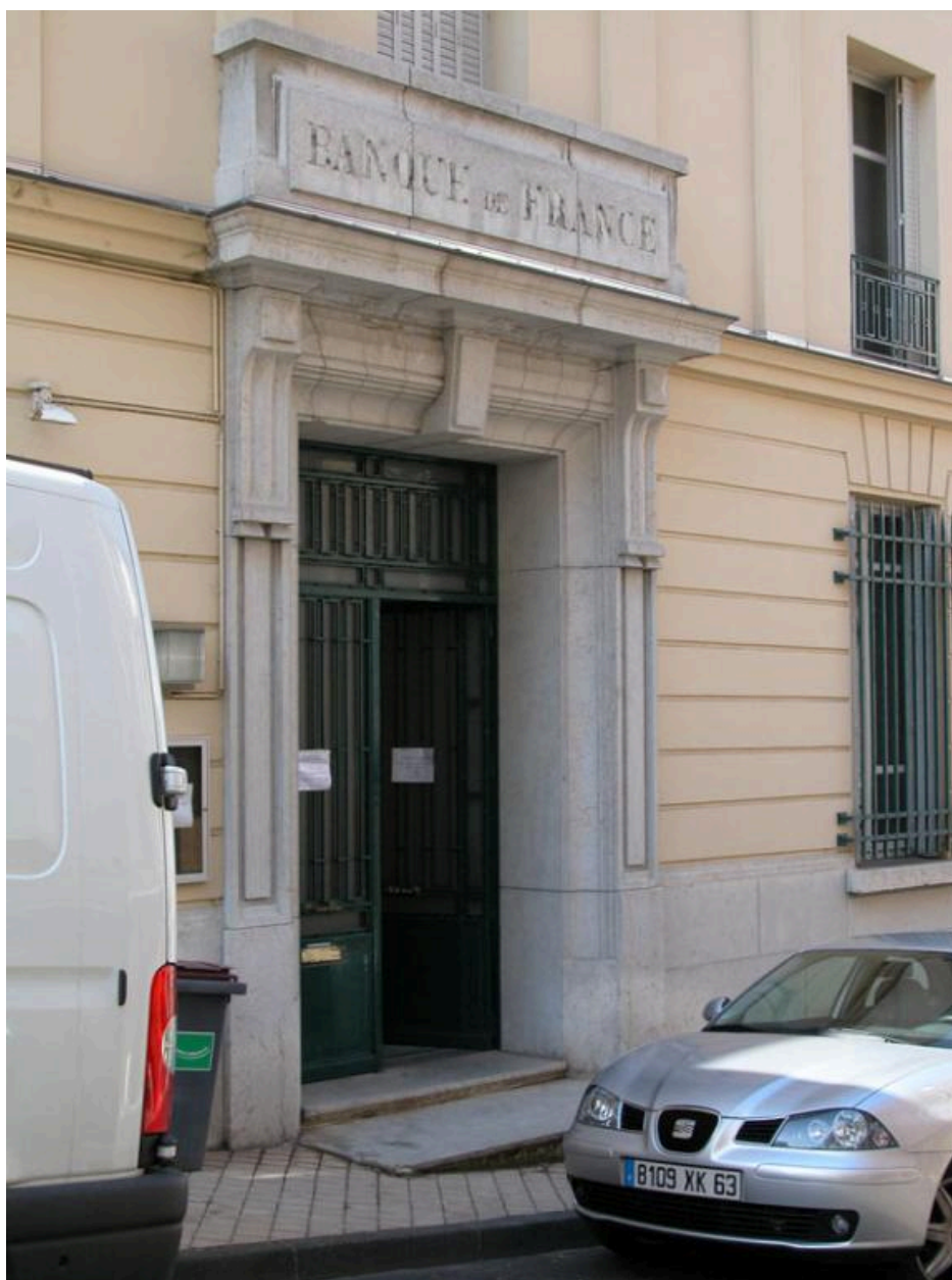
Porte principale d'accès du public à la banque, rue de Barante (photographie chercheur).
