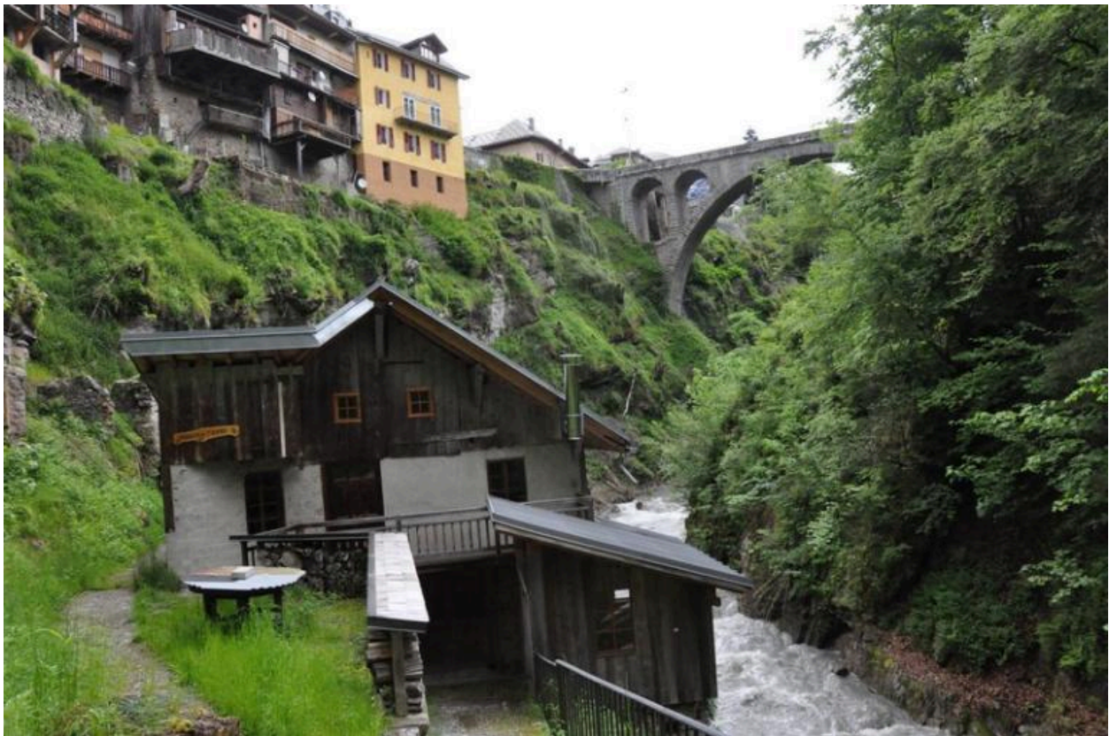
Pignon sud-ouest du moulin.
