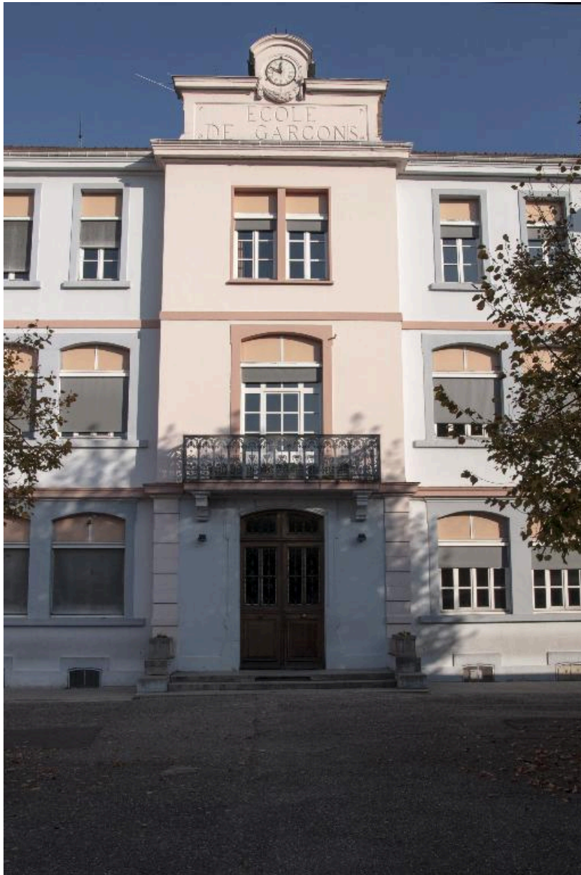
Travée centrale, façade principale
