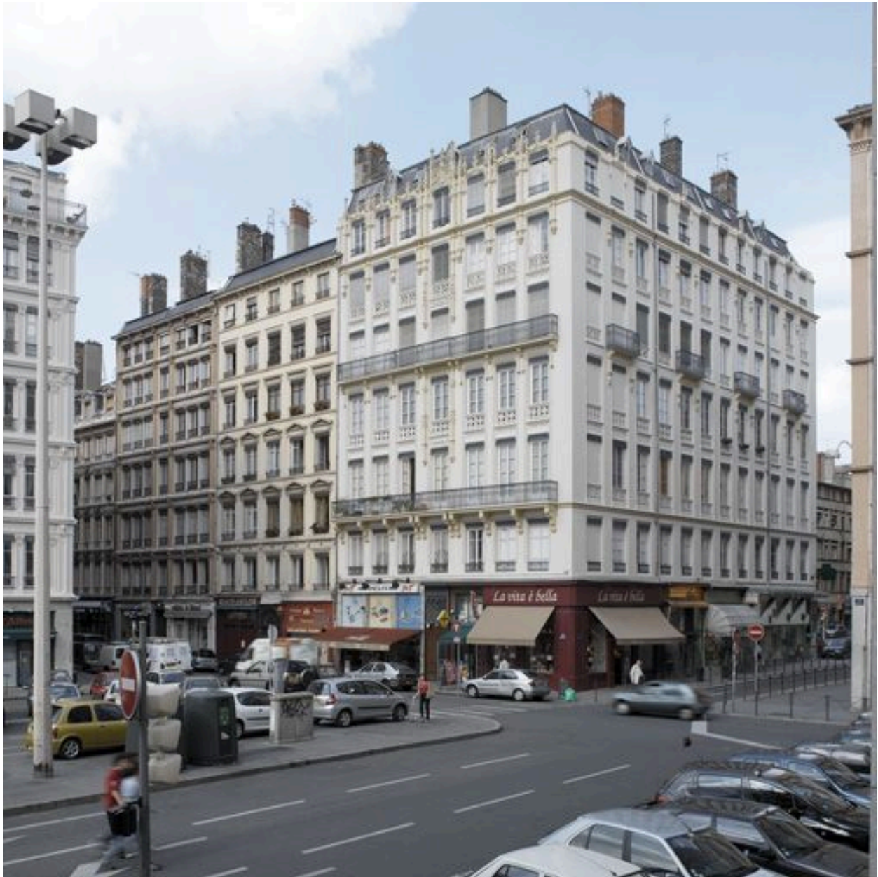
Vue générale des façades sur les rues Chavanne (façade principale) et des Bouquetiers
