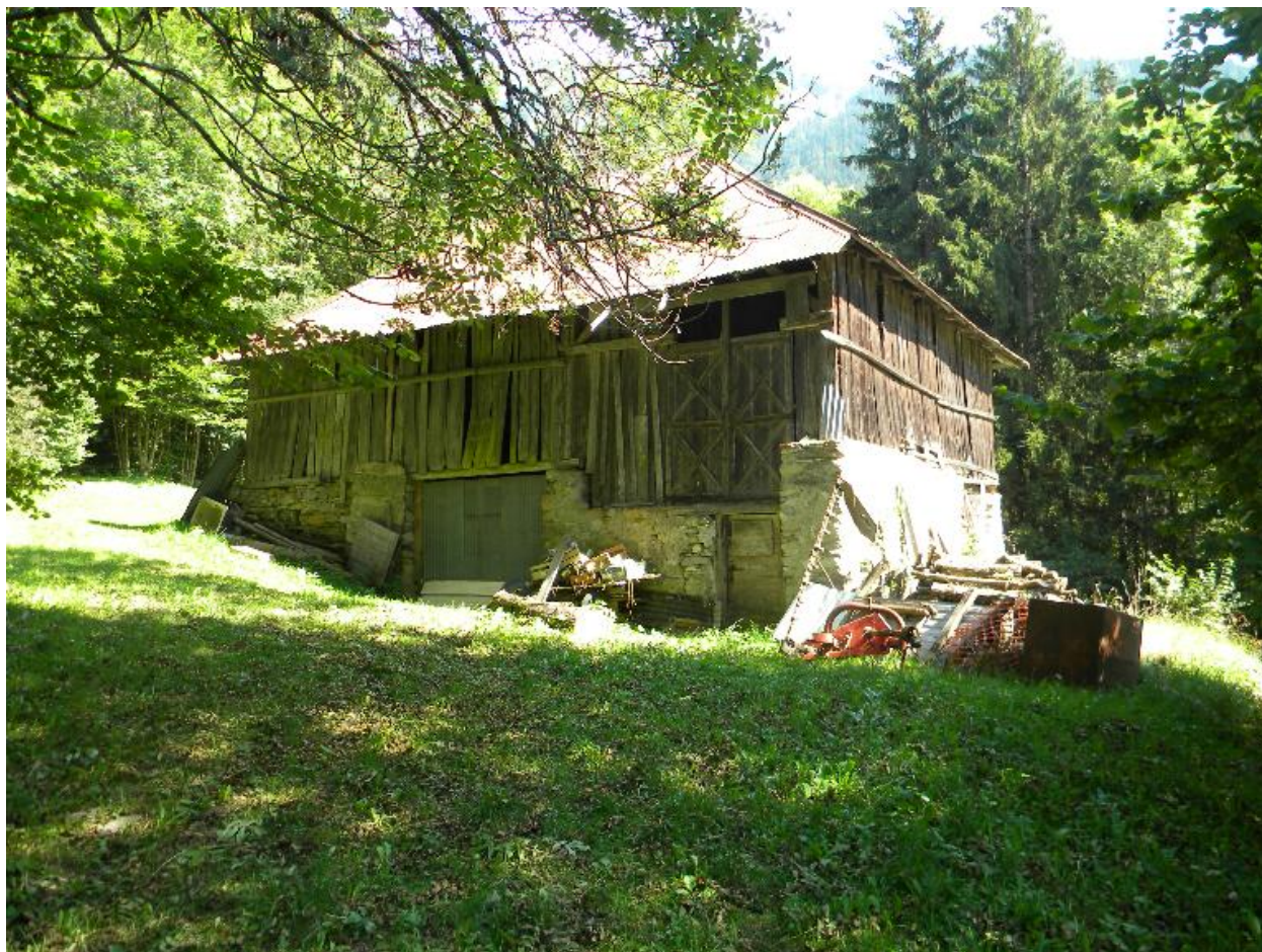
Vue d'ensemble d'une grange-étable (2008 E6 781,788,789).
