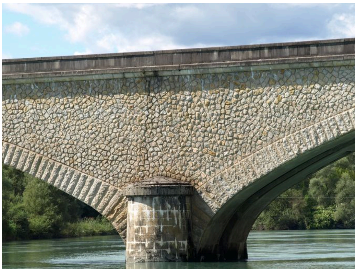
Pile, face amont (depuis la rive droite)
