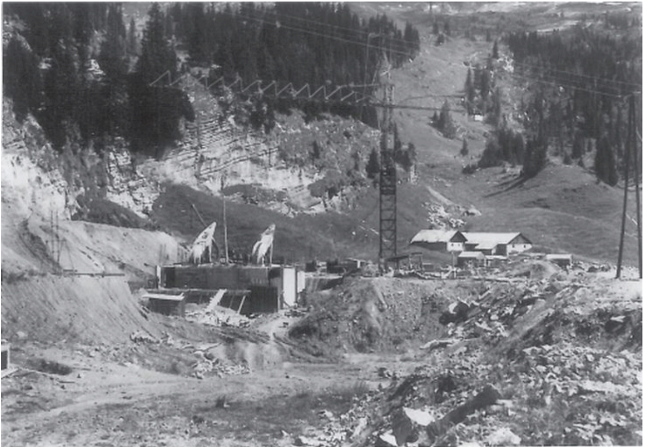
Construction des fondations de la gare, 1963 (A. privées Berlottier)
