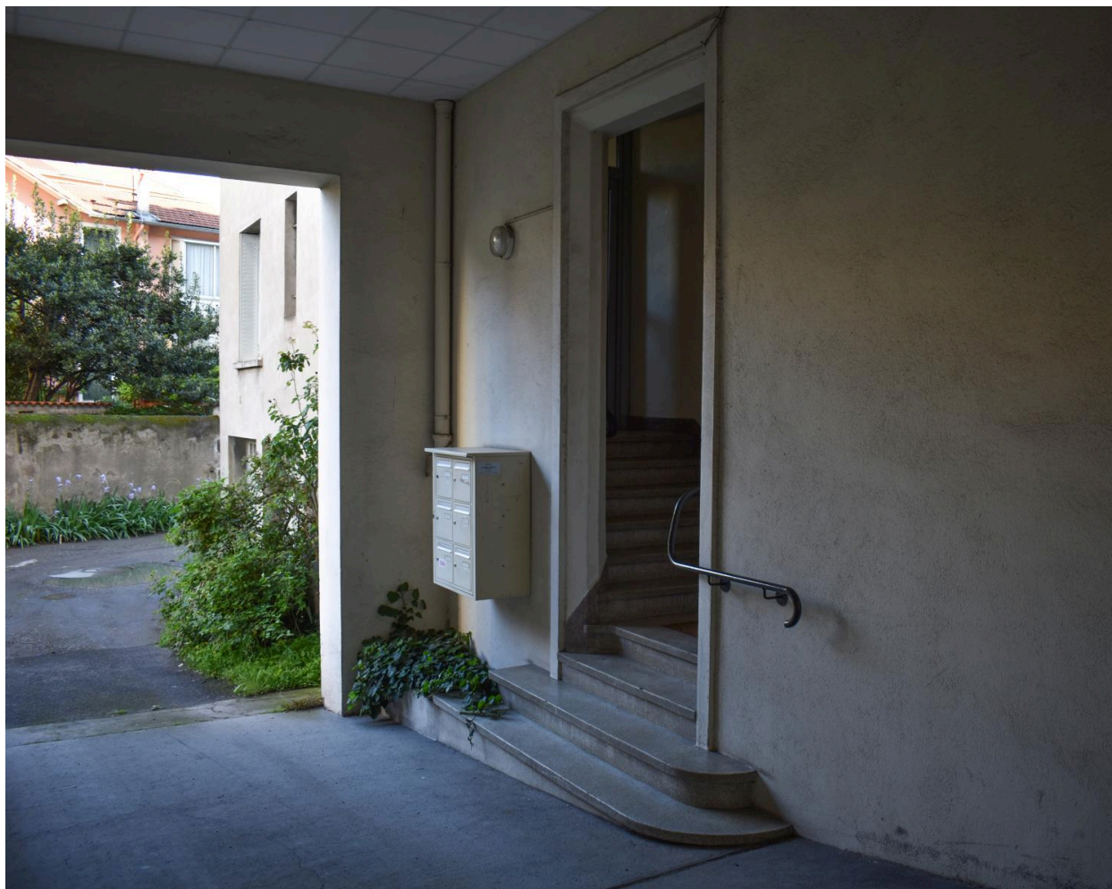
Passage carrossable et porte d'entrée latérale
