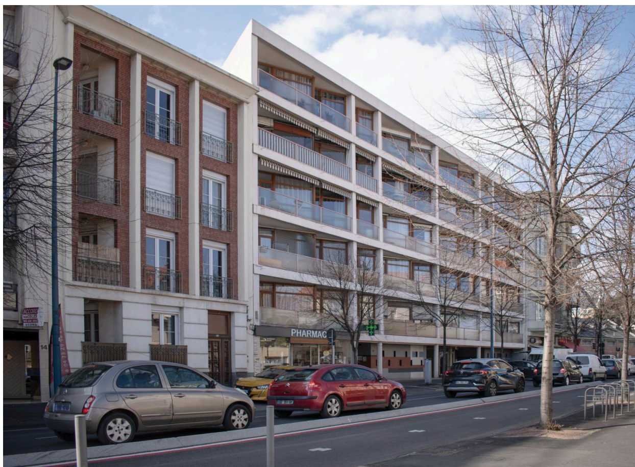
Façades sur le boulevard Aristide-Briand
