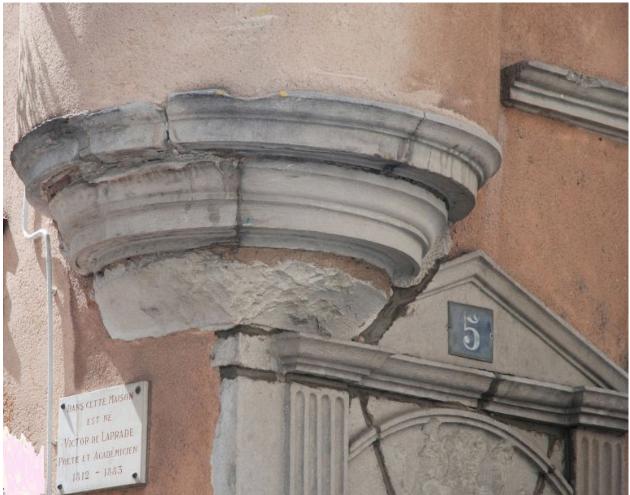
Encorbellement de l'échauguette d'angle.
