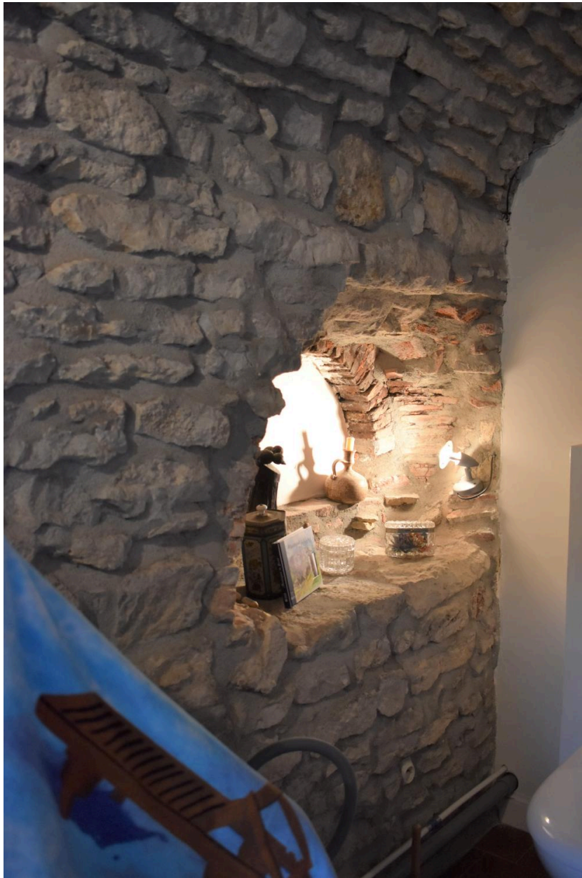
Ancienne gueule d'un four à pain, rez-de-chaussée.
