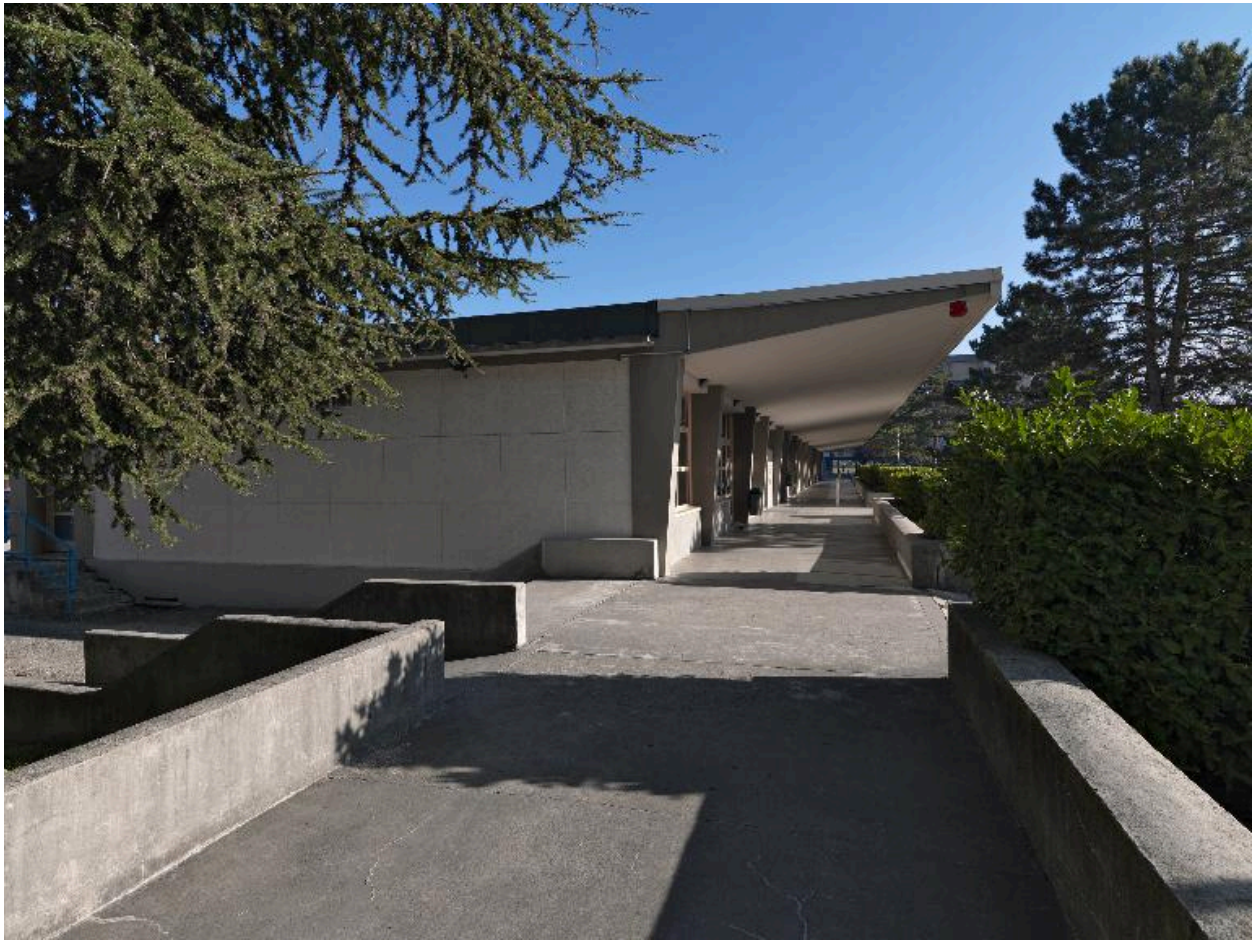
Restaurant scolaire, vue latérale depuis l'ouest
