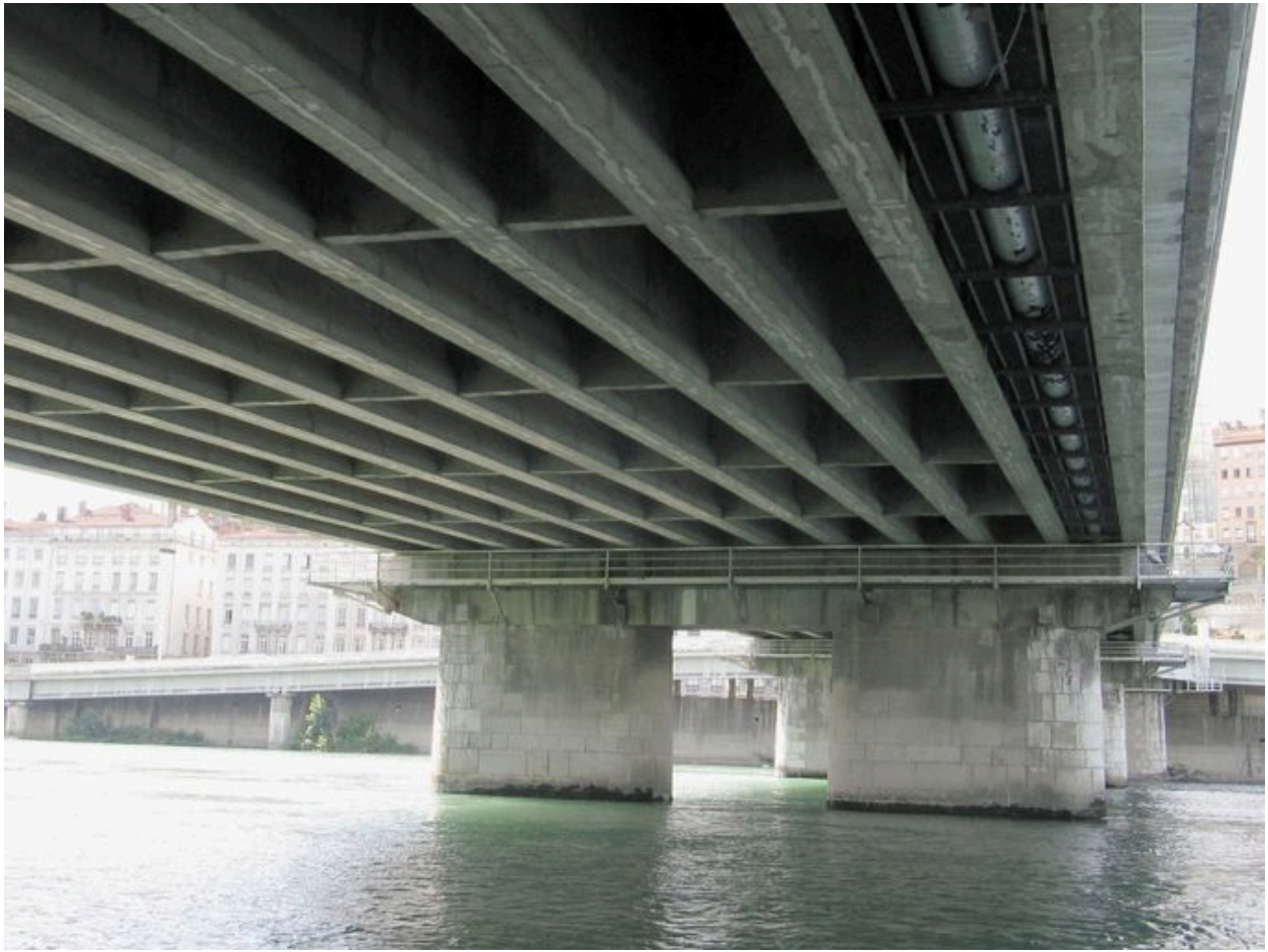
Vue partielle, de dessous, tablier et piles (depuis la rive gauche)
