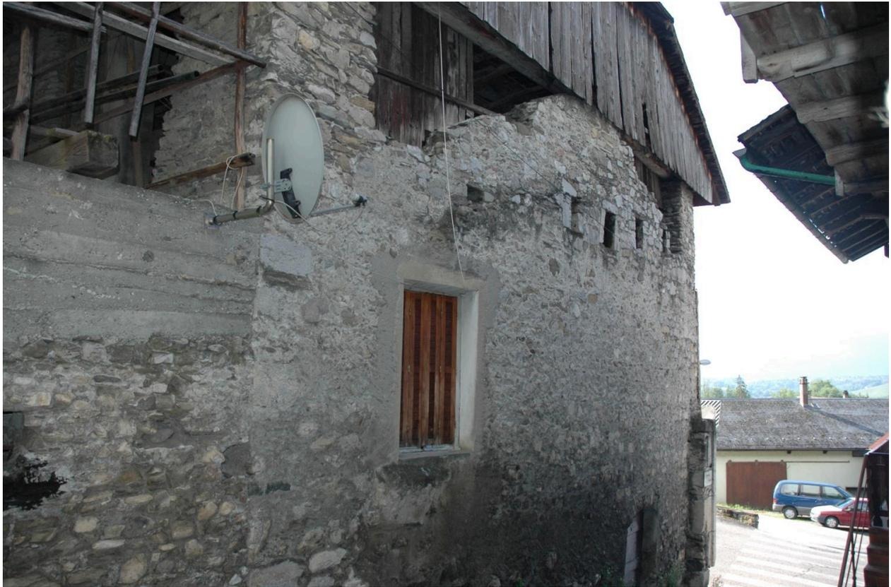
Élévation sur l'impasse des Carrières : rampants de l'ancien pignon, trumeaux maçonnés aux angles supportant la nouvelle charpente.
