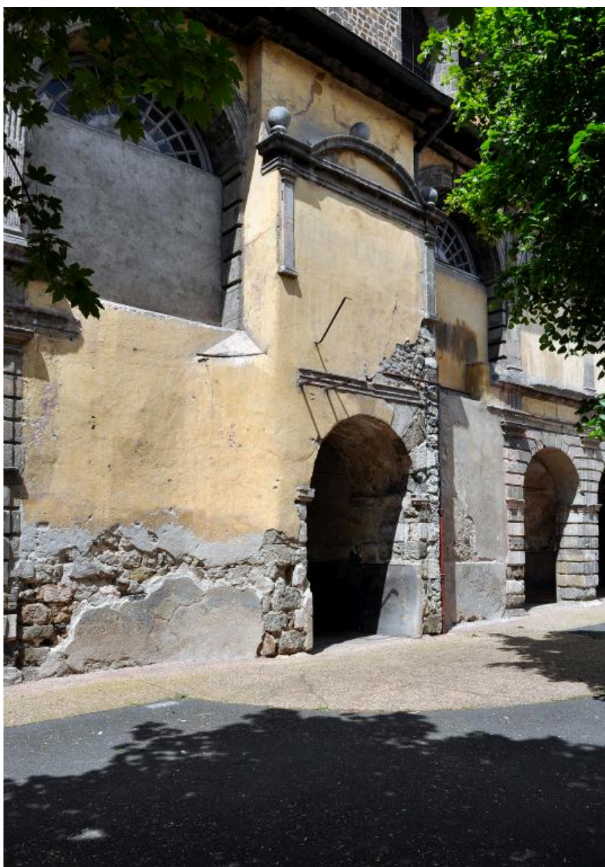
Galerie B : élévation, partie centrale depuis l'ouest
