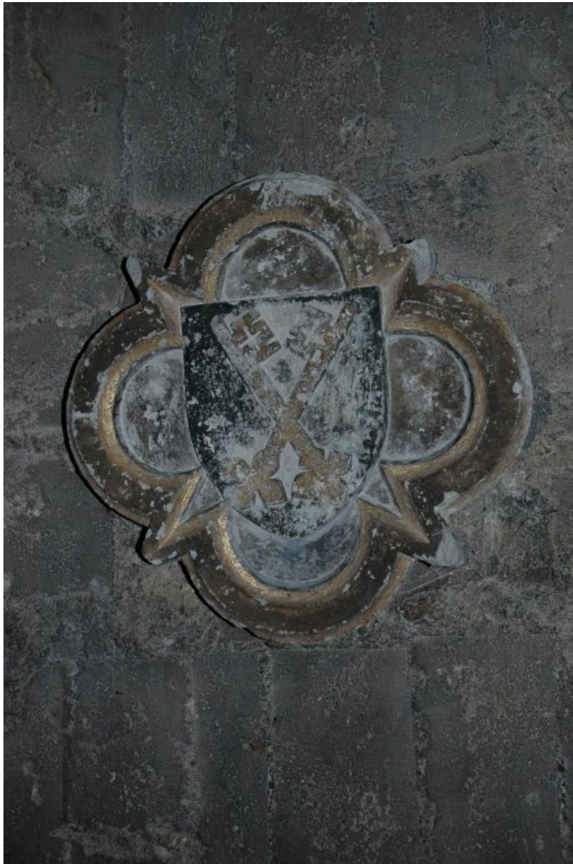
Clé de voûte dans l'étage de soubassement ornée d'armoiries meublées des 2 clefs croisées de saint Pierre
