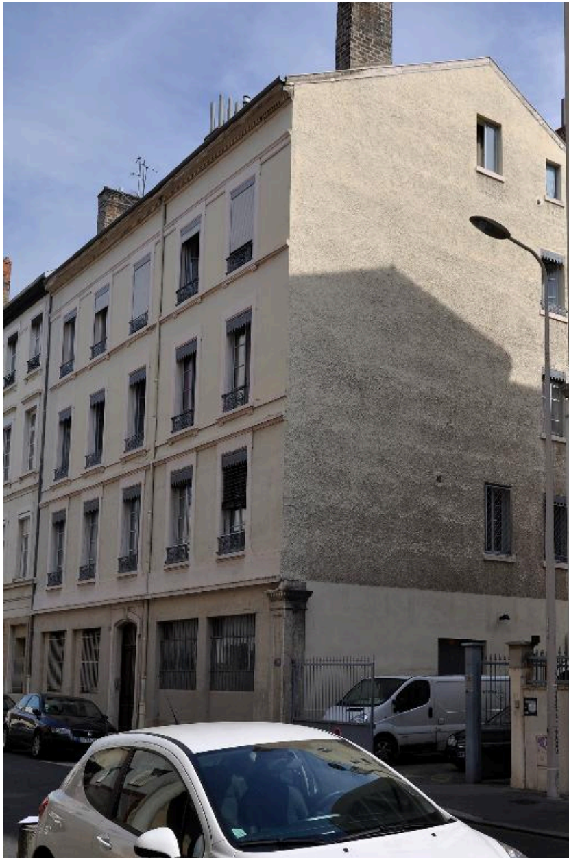
Immeuble, vue d'ensemble depuis le sud-est
