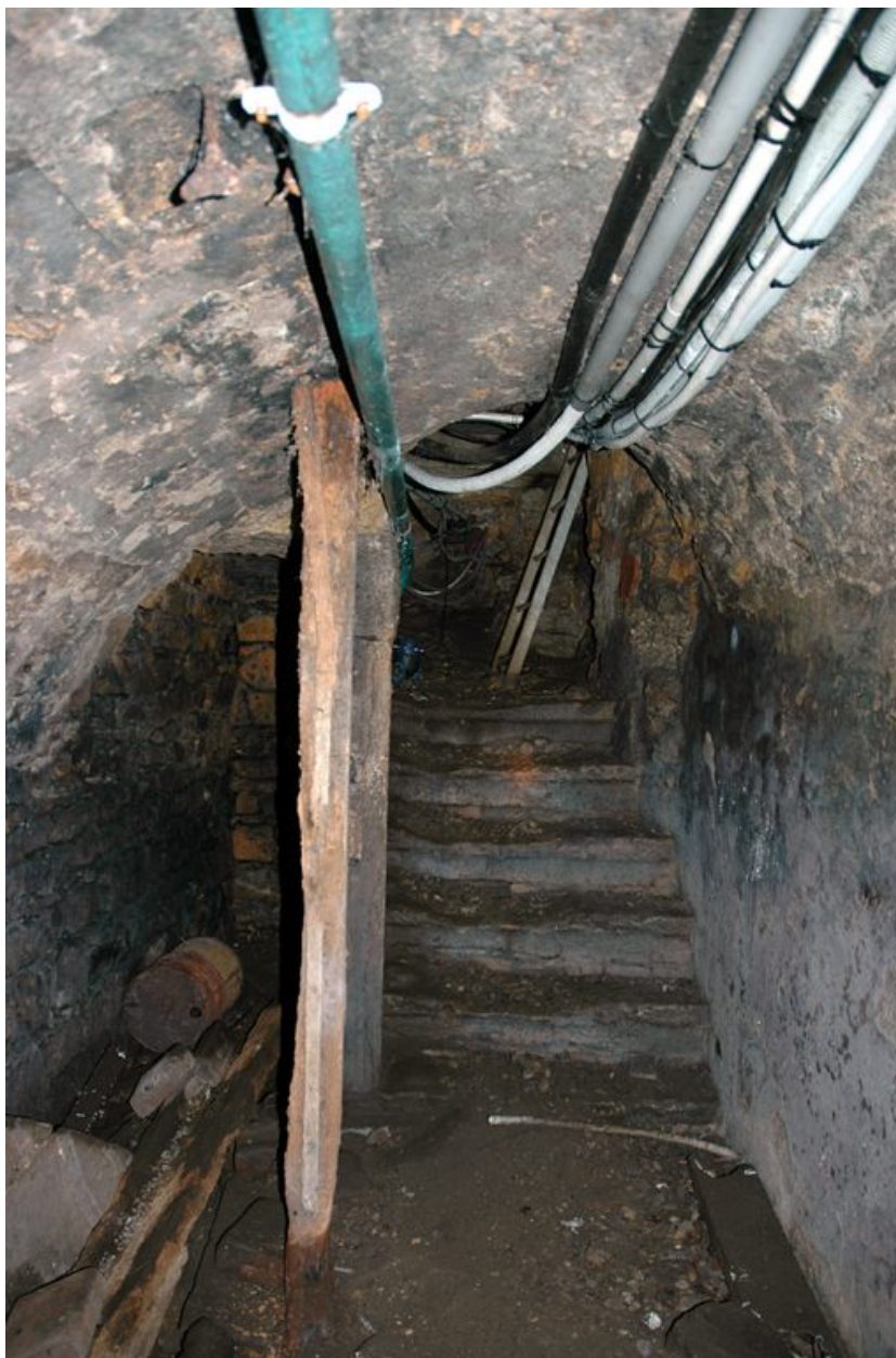
Couvent : 3 rue des Templiers, vue de l'escalier de la cave de l'actuel immeuble
