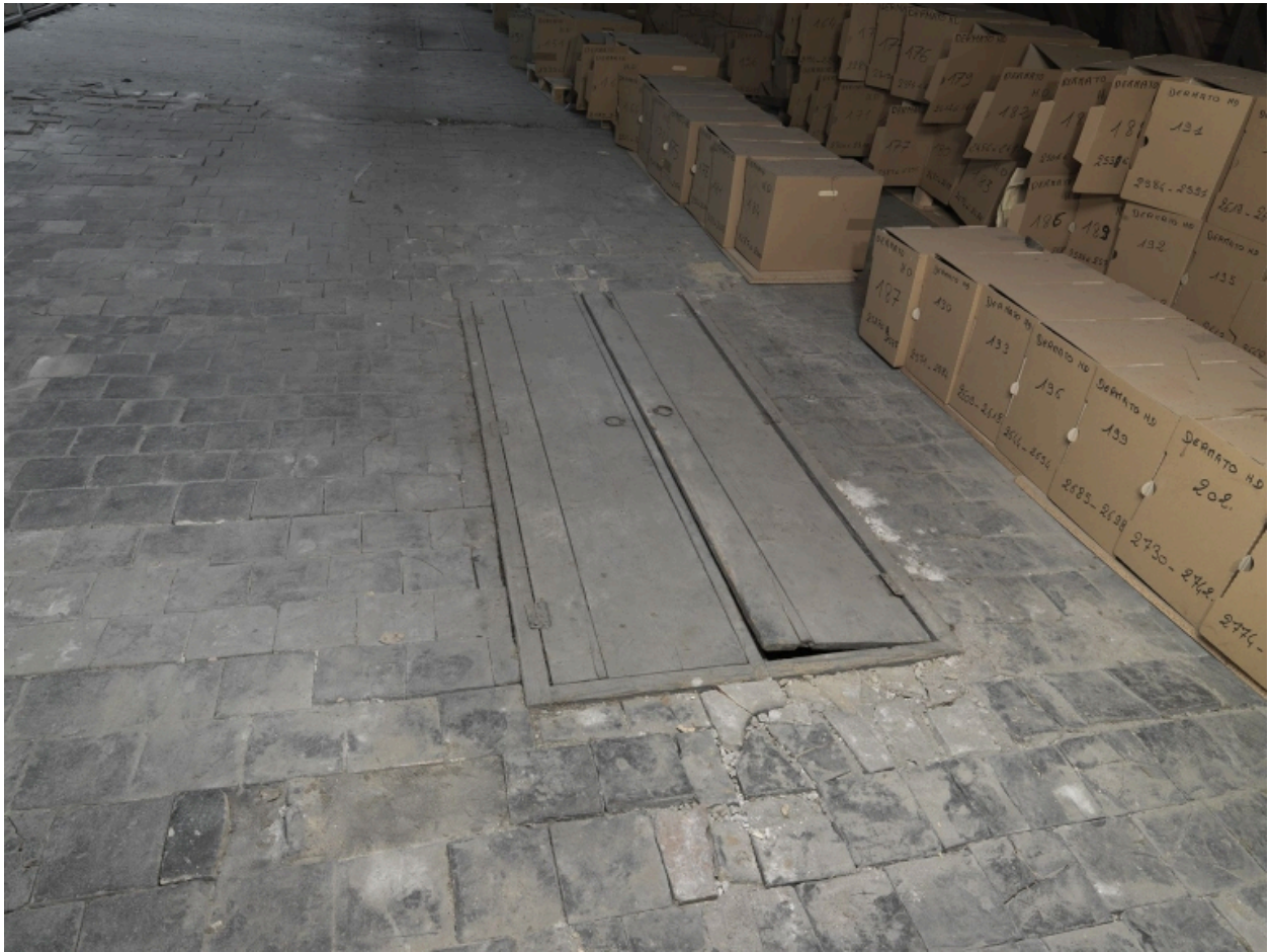
Bâtiment A. Etage de comble du corps de bâtiment le long du quai. Trappe de ventilation dans le sol, fermée
