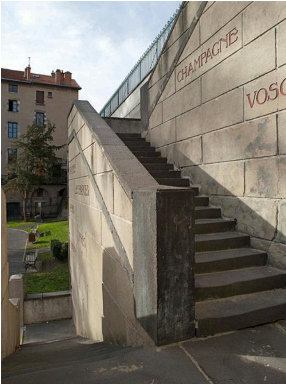
Vue partielle des volées doubles de l'escalier du monument.
