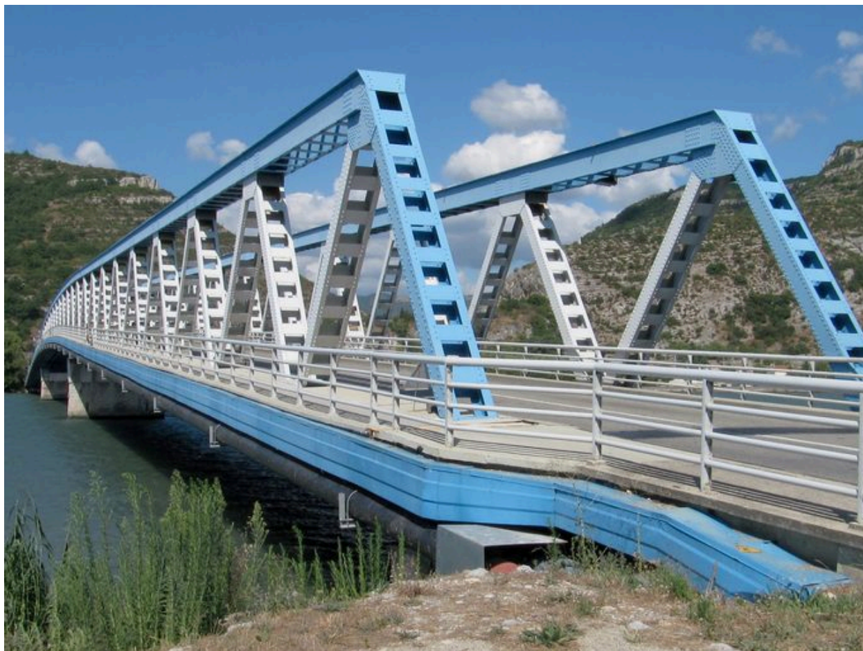
Vue du pont routier du Pouzin (Ardèche), depuis la rive gauche ; pont à poutre en treillis à travées continues (1961)
