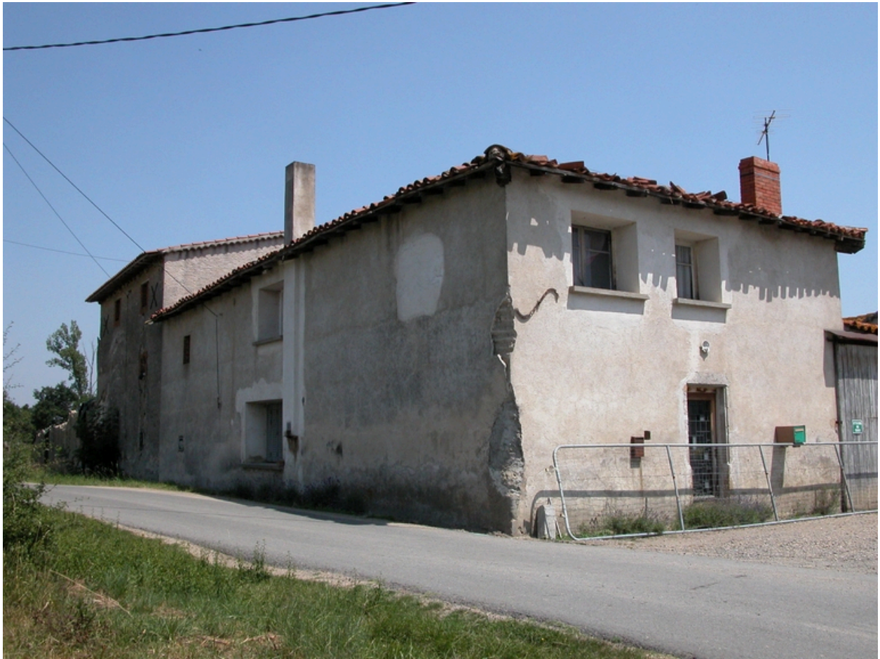
Vue d'ensemble du logis (élévation postérieure).
