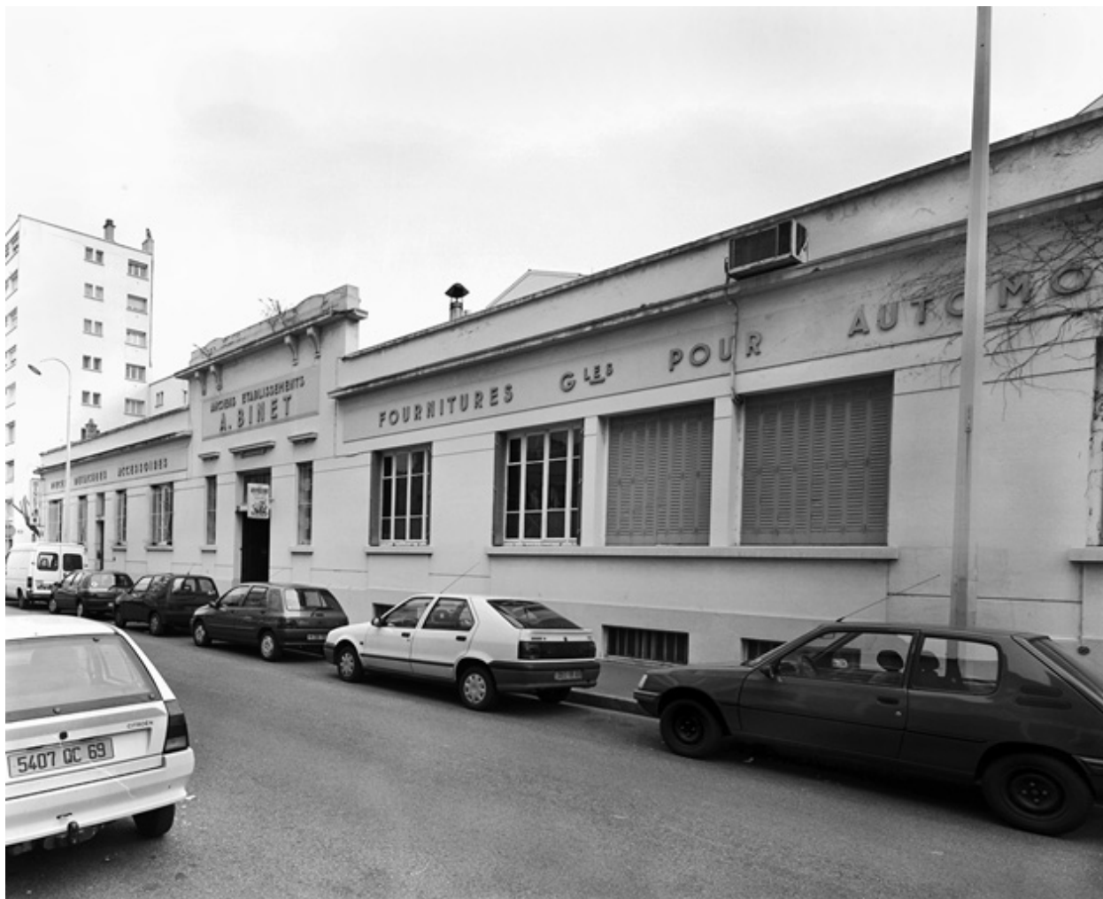
Vue générale nord
