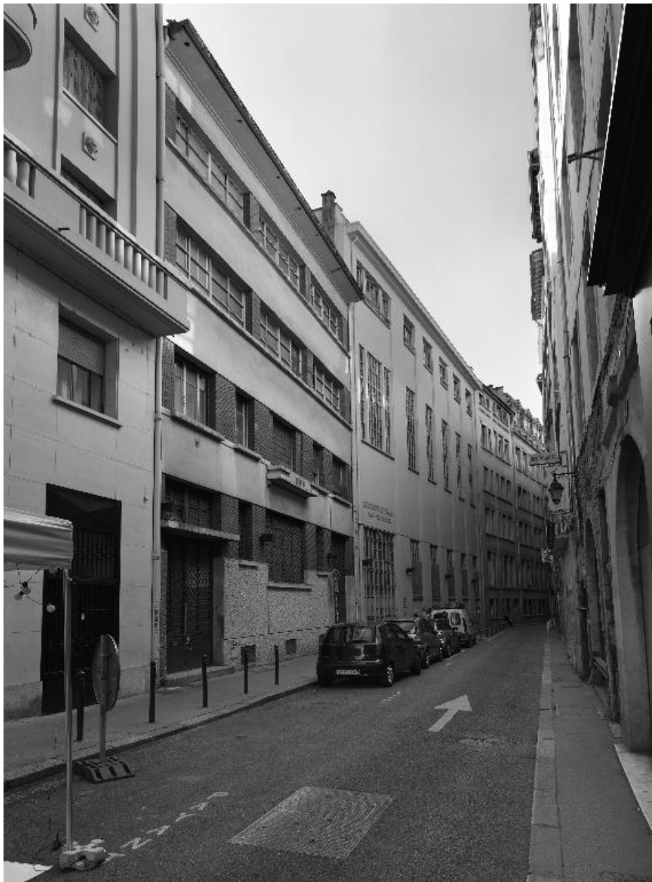
Vue générale de la sous station électrique
