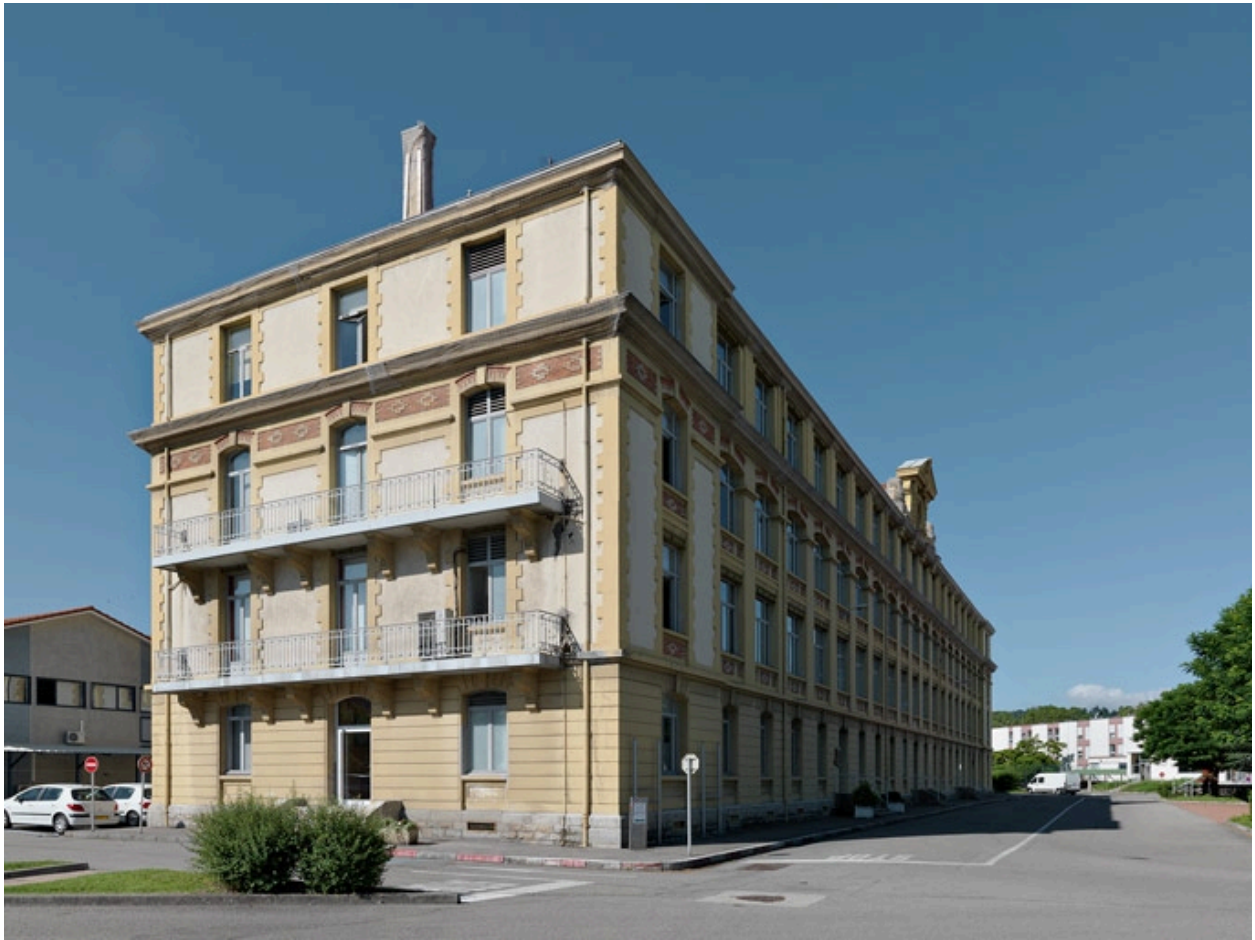
Pignon nord du bâtiment de 1916
