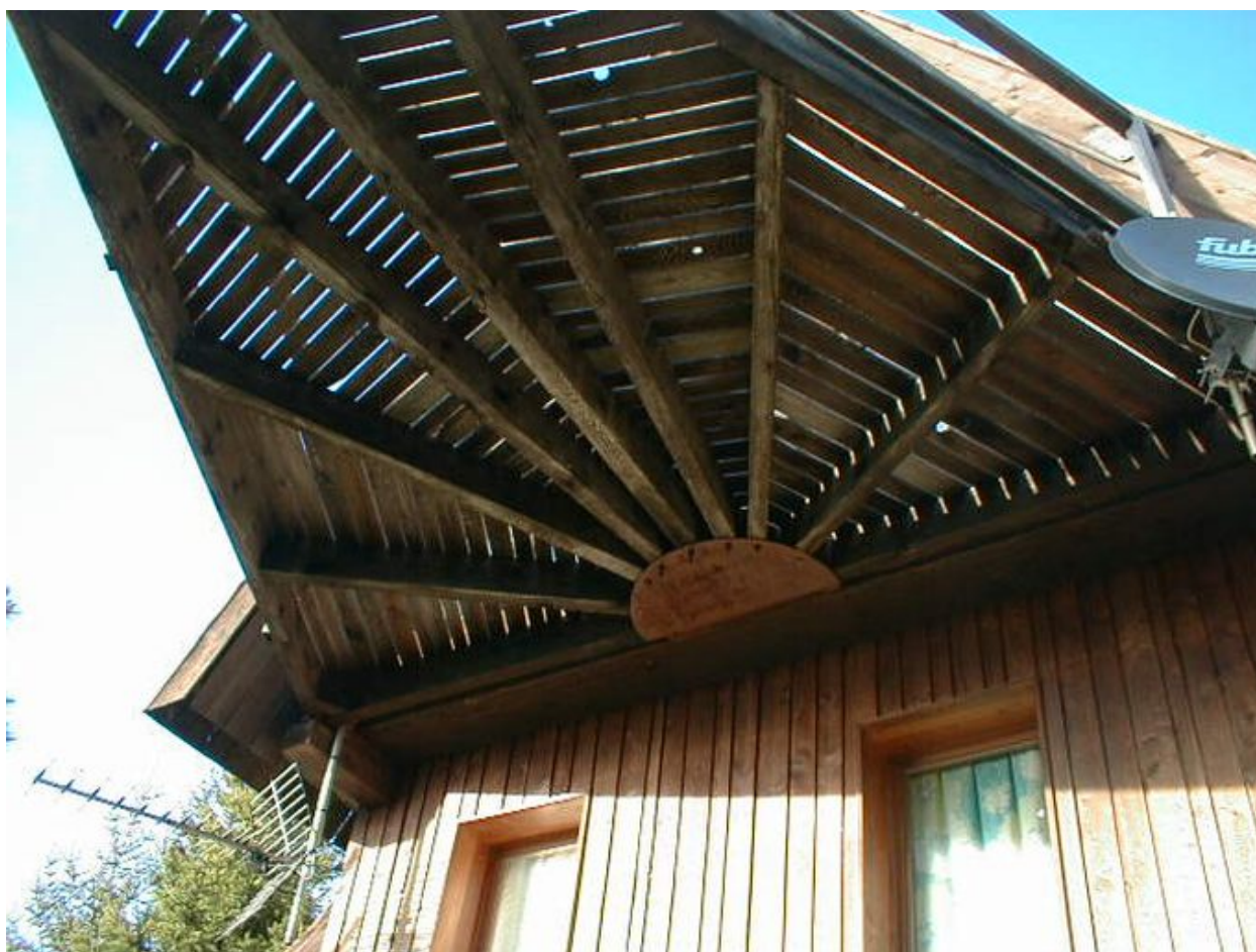
Chalet n° 20. La terrasse. Détail
